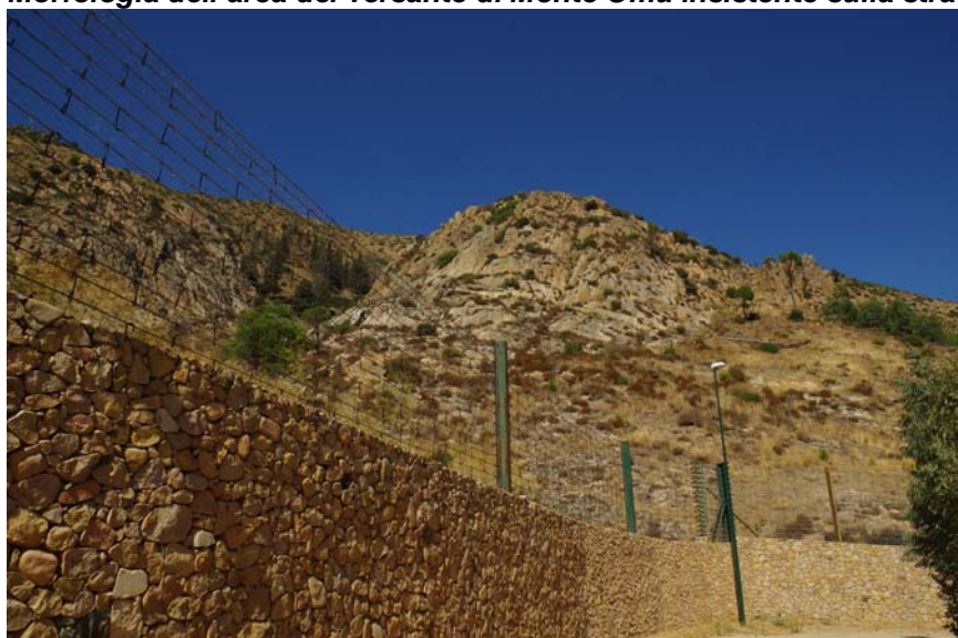
Foto sopra e sotto – I sistemi di rete paramassi fisse e elastiche che mitigano il pericolo sull'area a valle della panoramica
